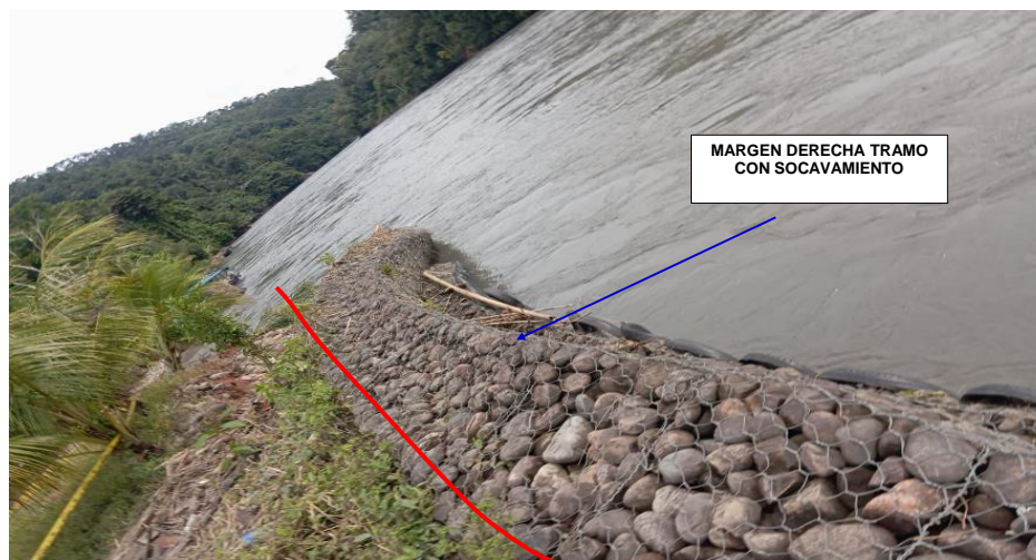
FIGURA N°03: EN LA TEMPORADA DE MAXIMAS AVENIDAS, EL RIO MADRE DE DIOS EN LA ZONA IDENTIFICADA EROSIONA EN LA MARGEN DERECHA
